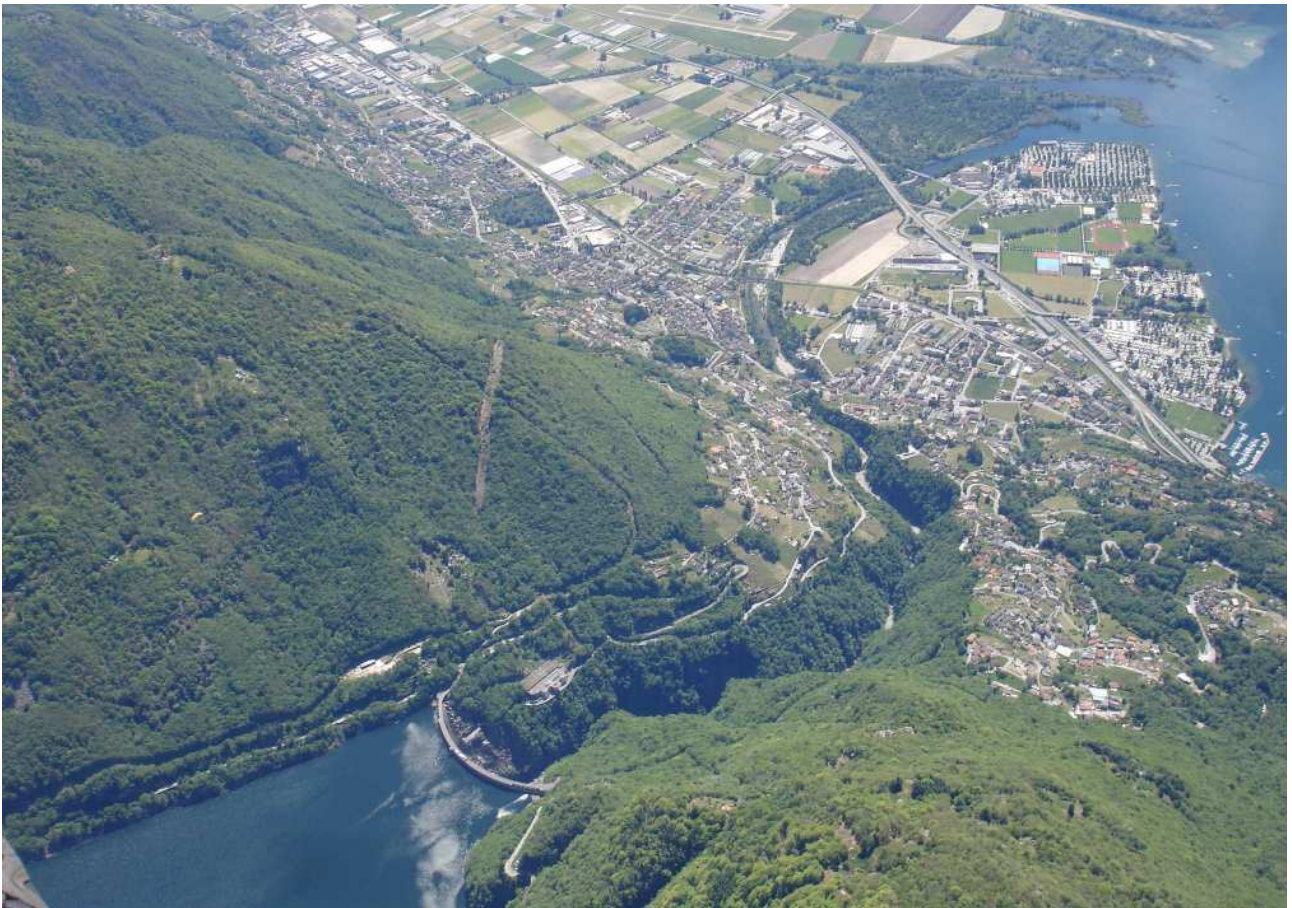
Staumauer vorne am Verzascatal.
